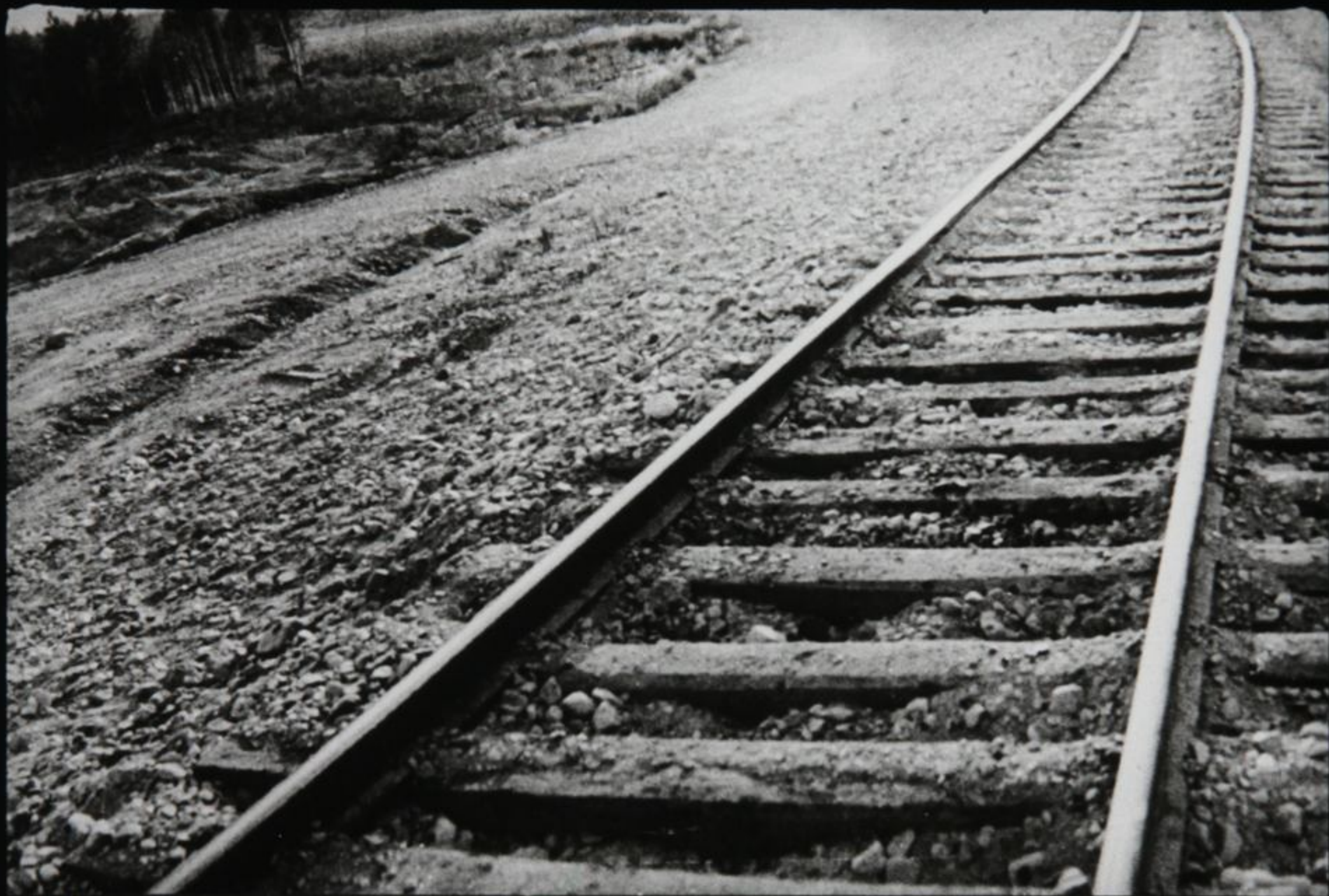
Построить железнодорожную линию Тында—Беркакит.
